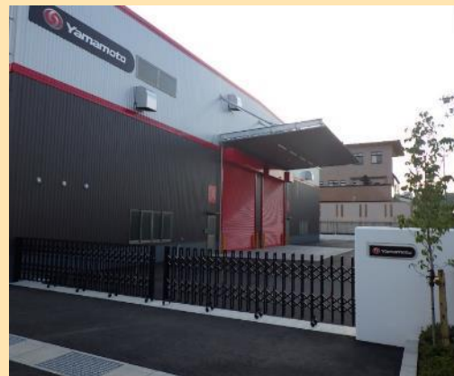
民間 重量鉄骨造建築
