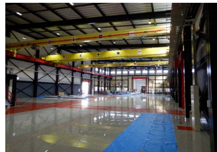
重量鉄骨造建築の工場棟内装
