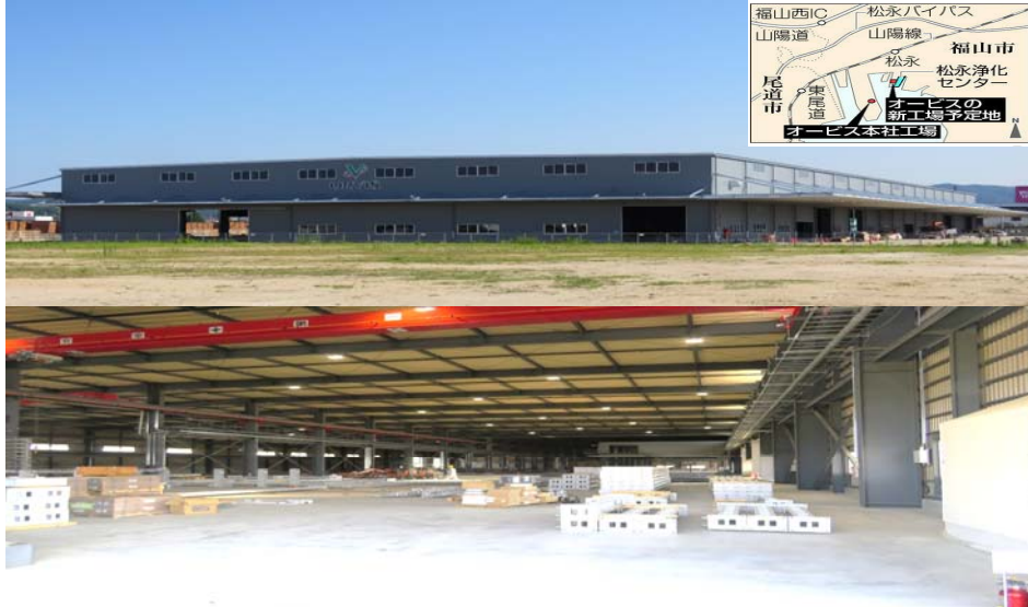
✓ 福山工場建設現場（2017年06月14日撮影）
