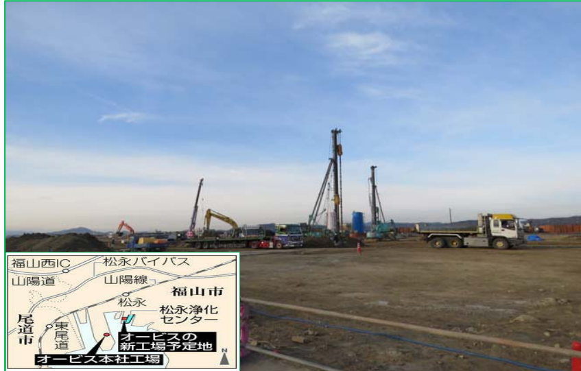
✓ 福山工場建設現場（2016年12月12日撮影）
