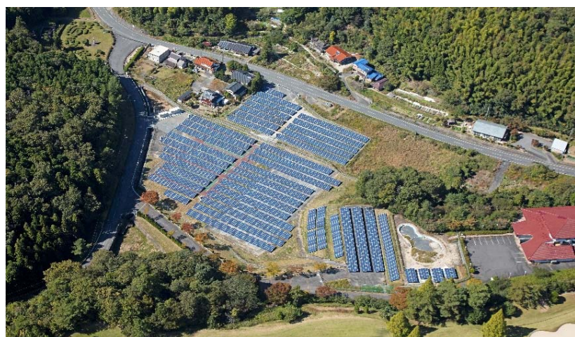
自社太陽光発電設備(山口県周南市 941kW)
