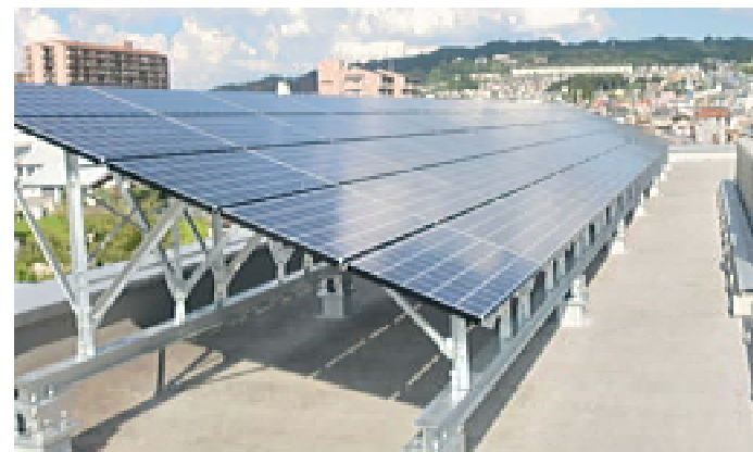
太陽光パネル施工例
