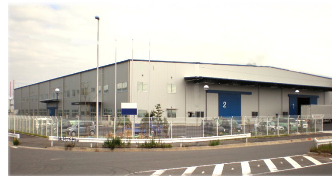
システム建築施工例
