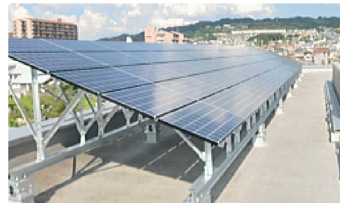
太陽光パネル施工例
