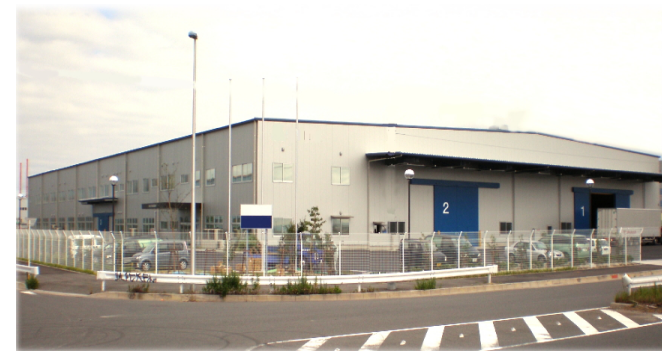
システム建築施工例
