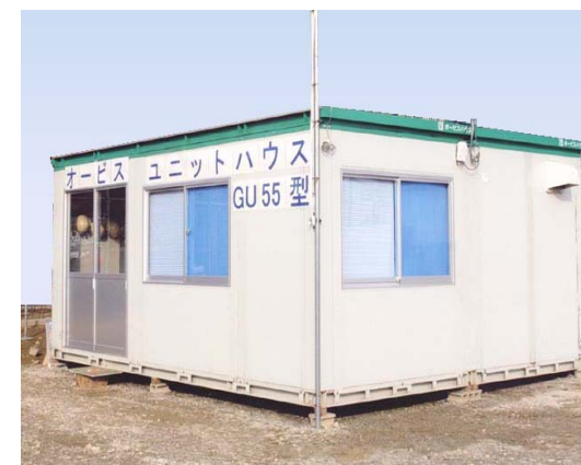
ユニットハウス施工例
