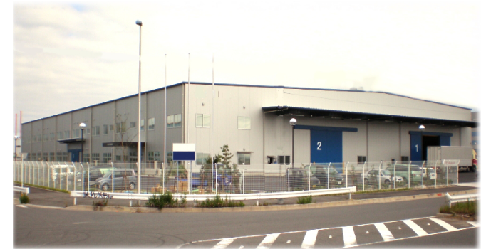
システム建築施工例
