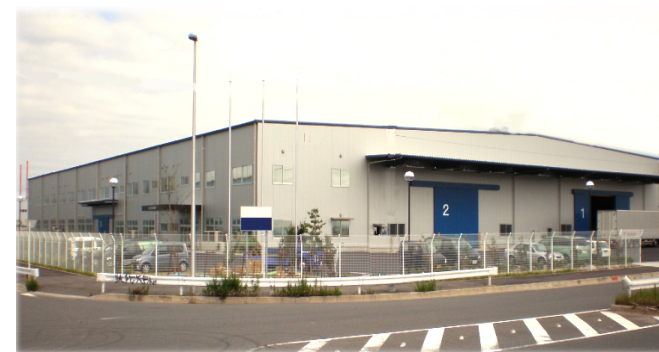
システム建築施工例
