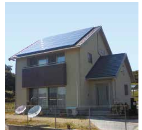
住宅用太陽光発電システム(4.44kW)施工例
